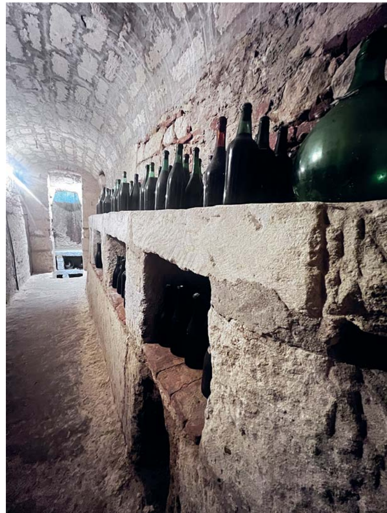
Infernot una piccola camera sotterranea scavata a mano nella Pietra da Cantoni
