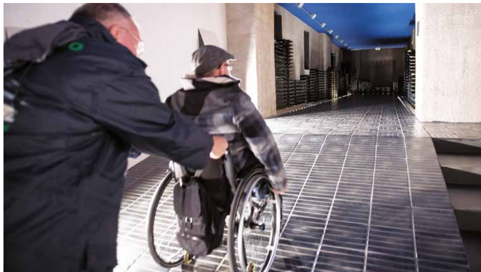
Figura 29 - Rampa e gradinata affiancate, per l'accesso alle Cantine Ascheri, Bra (CN).
