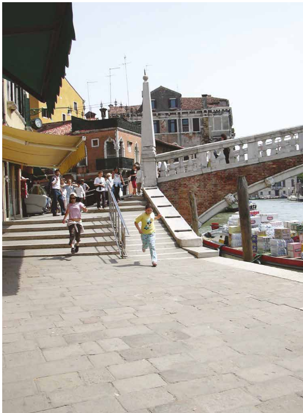
Figura 33 - Affiancamento di gradinata e di rampa a gradino agevolato al ponte delle Guglie a Venezia.
