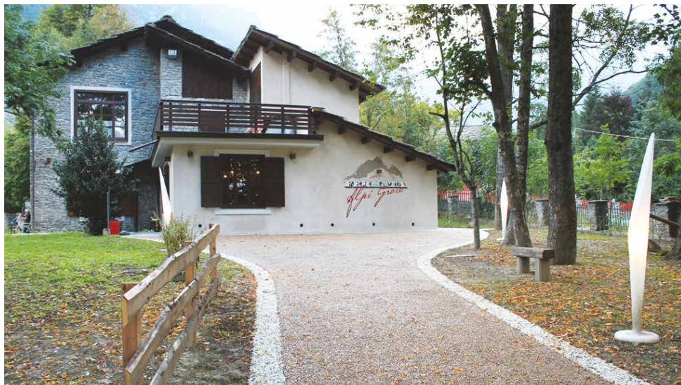
Figura 15 - Rivestimento del percorso esterno con materiale stabilizzato e bordi laterali con funzione linee guida. Fermata Alpi Graie, Groscavallo (TO).
