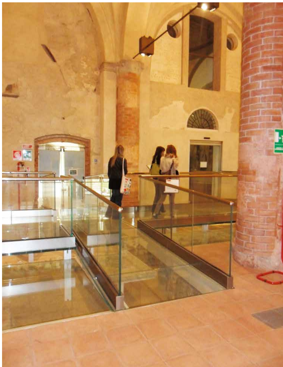
Figura 22 - Percorso con rampa e passerella orizzontale in vetro di sicurezza per consentire di vedere aree, a un livello sottostante, non raggiungibili dal pubblico (ex Chiesa di San Francesco a Cuneo).
