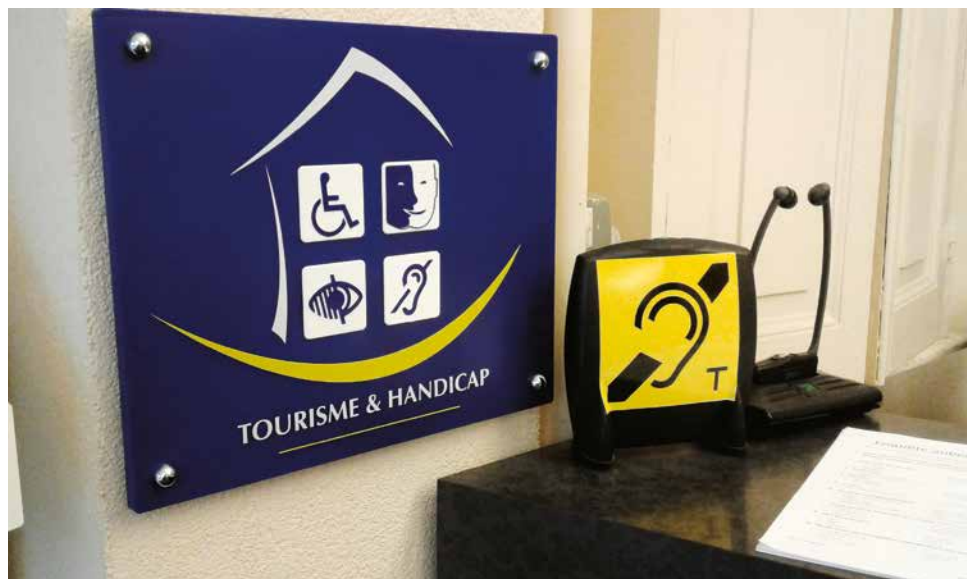
Figura 12 - Pannello a induzione magnetica per agevolare la comunicazione con persone ipoudenti, che utilizzano un dispositivo acustico dotato di bobina telefonica. Ufficio del turismo di Briançon.
