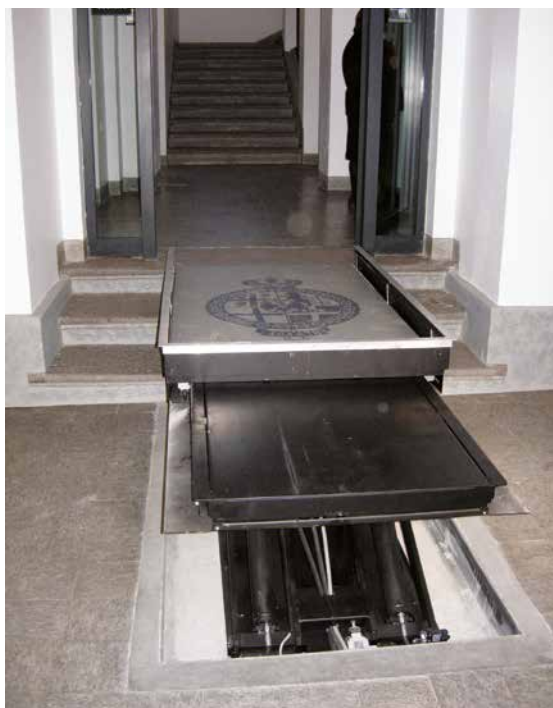
Figura 35 - Traslo-elevatore in movimento per l'accesso alla Pinacoteca dell'Accademia Albertina di Belle Arti, Torino.
