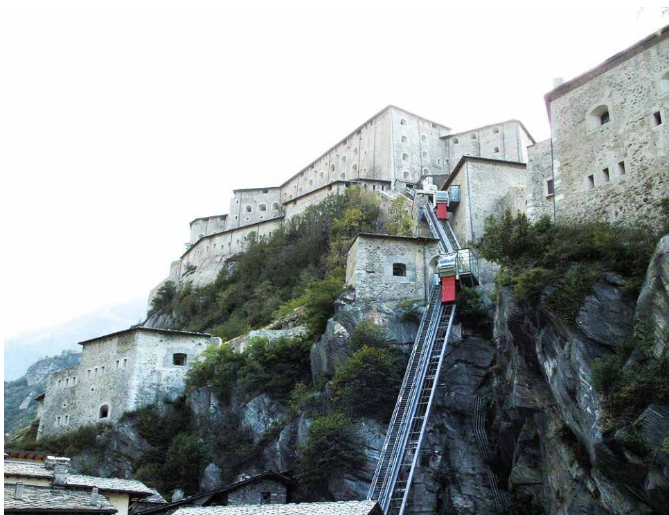
Figura 30 - Ascensori panoramici in sede inclinata per agevolare l'accessibilità al Forte di Bard, Bard (Valle d'Aosta).
