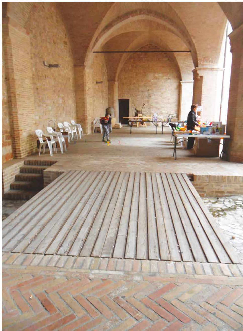
Figura 17 - Passerella in legno per rendere accessibile la corte di Palazzo Trinci a Foligno.
